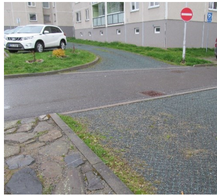
Vodopriepustný povrch parkovacieho miesta zaisťujúci infiltráciu vody do pôdy (Odry, ČR)
