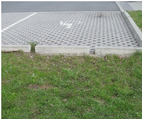
Odvod zrážkovej vody cez obrubníky do zelene (Bruntál, ČR)
